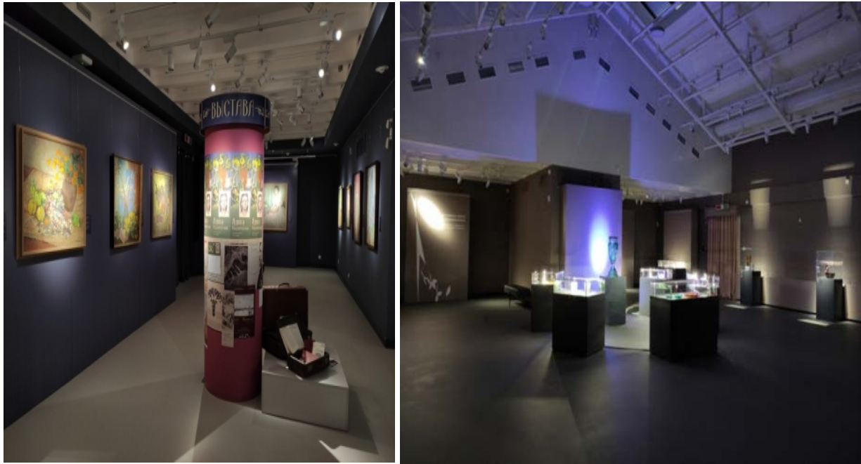
Рис. 10, 11. Трековая система подсветки, расположенная на потолке в Выставочном корпусе (ул. К. Маркса, 24)
